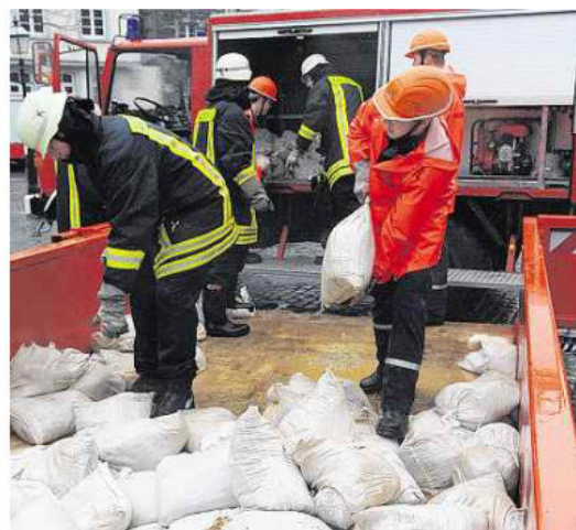
Das Mittel der Wahl gegen Wassermassen: Hunderte Sandsäcke wurden per Lastwagen nach Kornelimünster gekarrt. Auch die Jugendfeuerwehr packte kräftig mit an. Foto: Michael Jaspers
