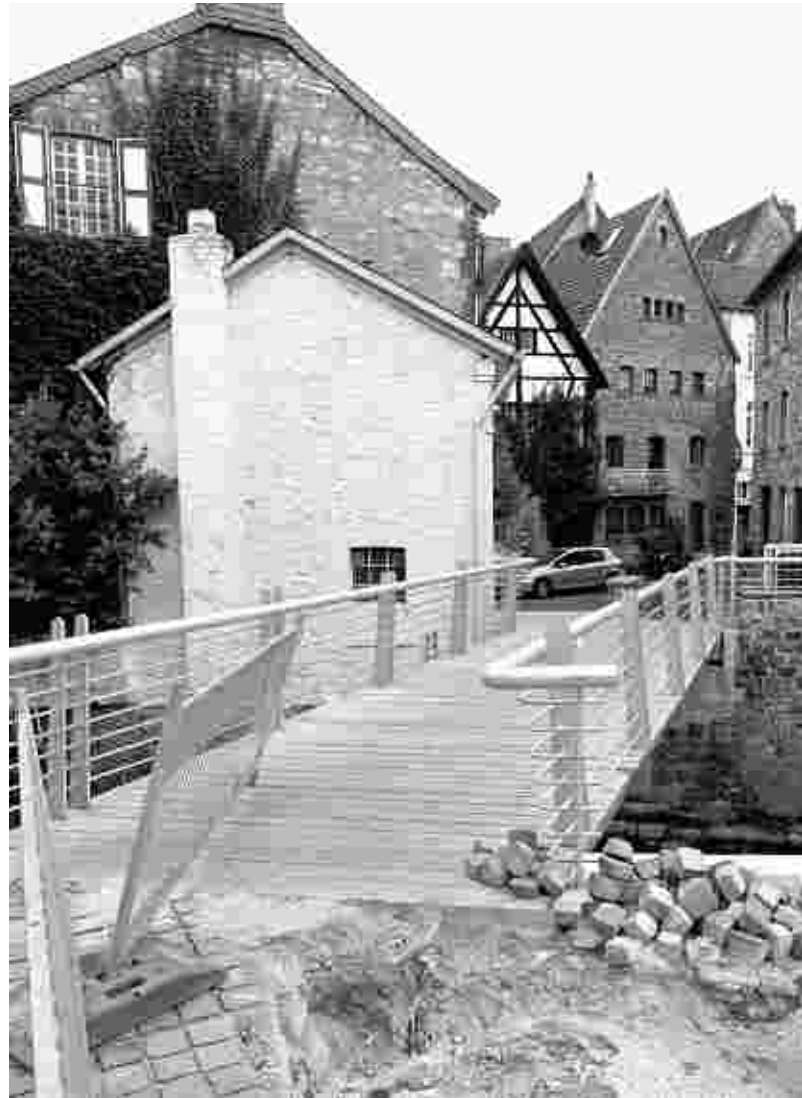
Eine kleine Baustelle bleibt: Weil zwischen dem Pflaster der Fußgängerbrücke über die Inde und der neuen großen Indebrücke eine 30 Zentimeter hohe Kante ist, muss eine Rampe gebaut werden. Geplant war der Höhenunterschied nicht. Foto: Wolfgang Piltzner
