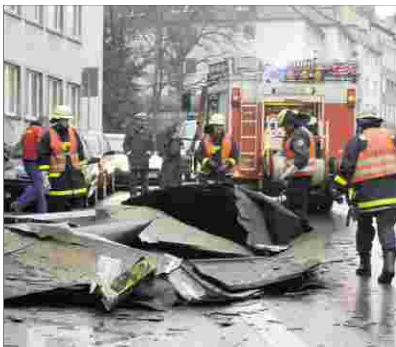
Glück gehabt: Als sich am Boxgraben ein Dach selbstständig machte, hätte deutlich Schlimmeres passieren können.
