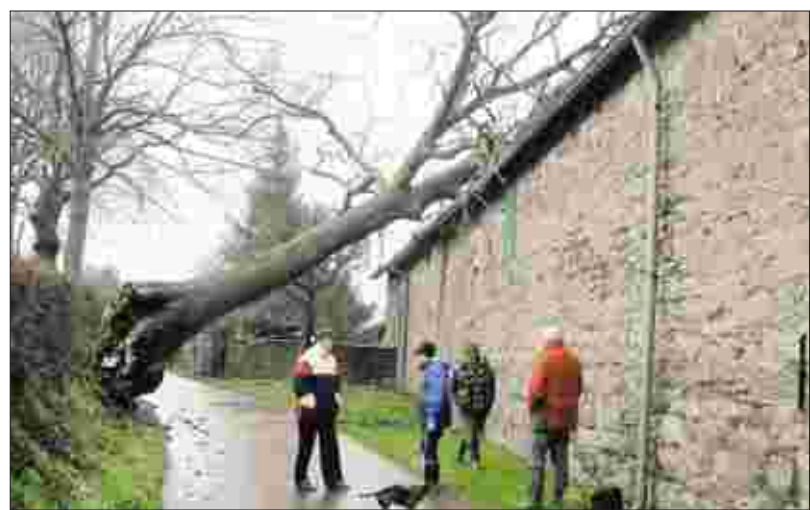
Dachschaden: Die Anwohner am Baumgartsweg in Sief hatten einen ungebetenen Gast aus Holz. Foto: Kurt Bauer
