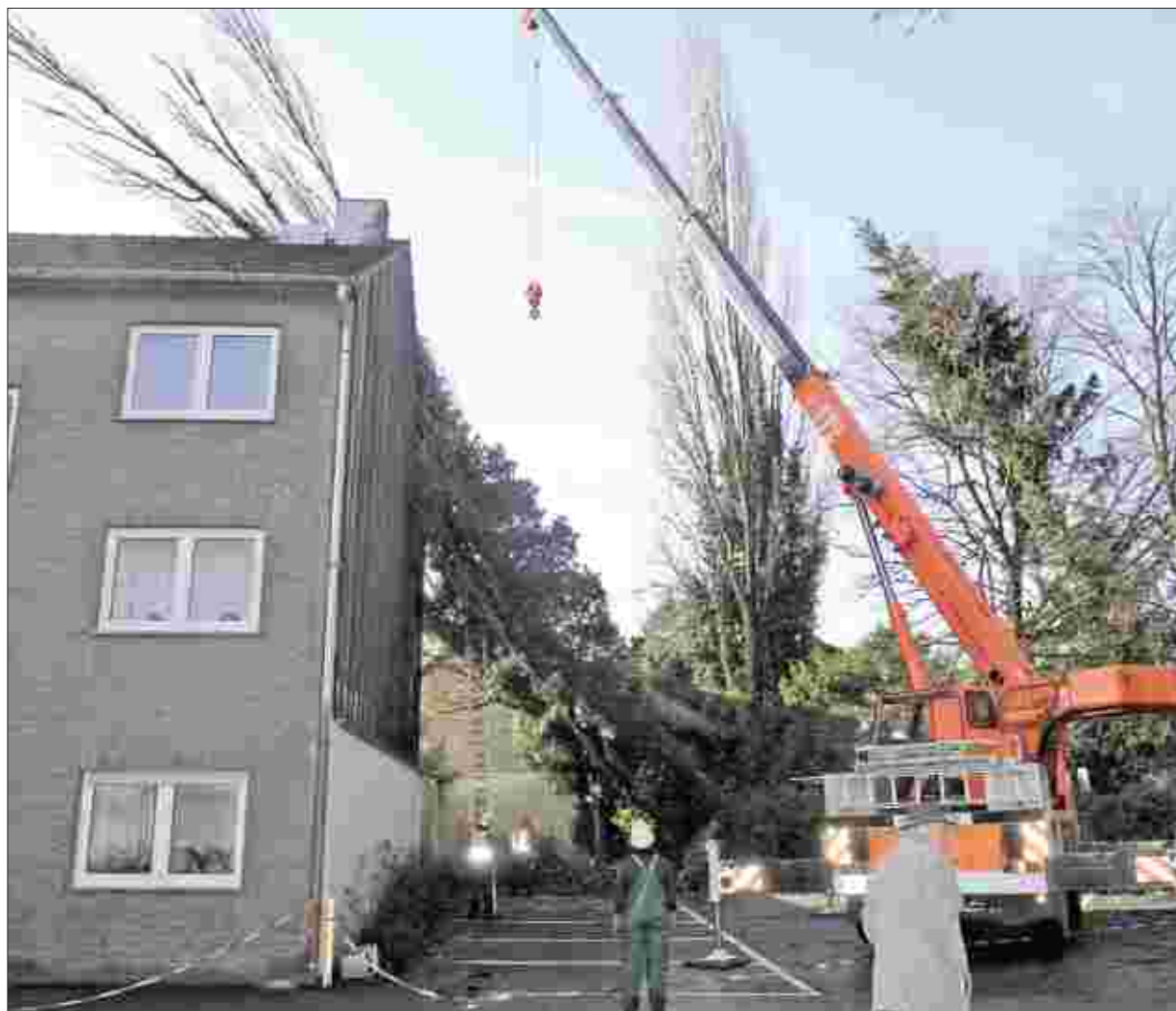
Aufs Dach gelegt: Mit dem Kran musste die Feuerwehr an der Alt-Haarener-Straße anrücken, um ein Haus von einer großen Pappel zu befreien. Sie war ein Opfer von „Kyrill“ geworden. Foto: Wolfgang Piltzner
